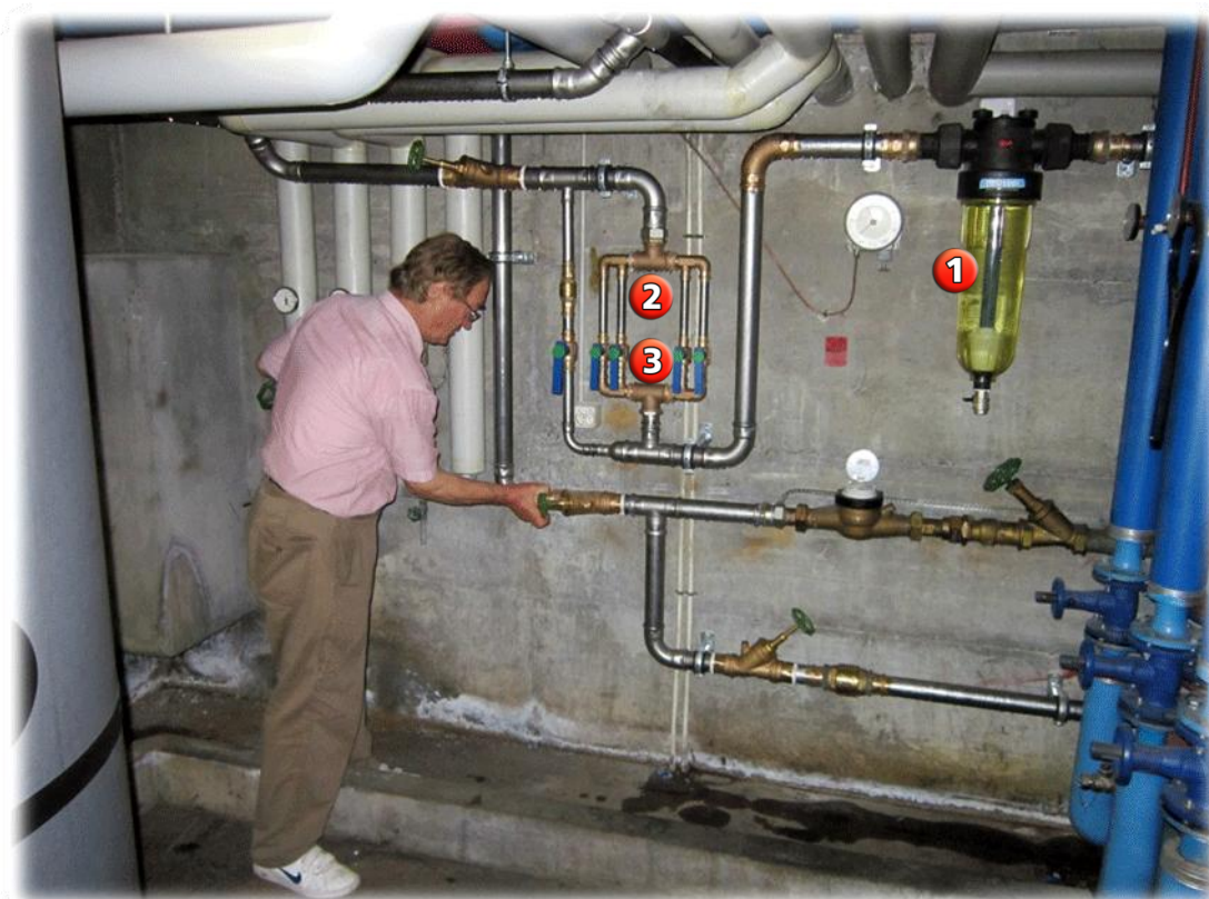
Installation pour un immeuble de 35 appartements
